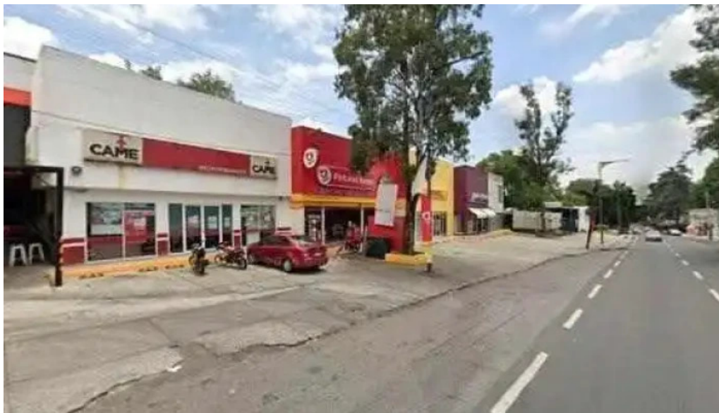
Carretera federal a cuernavaca la joya zona
