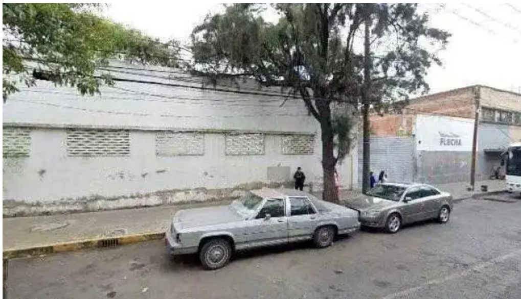
Estacion metro potrero direccion
