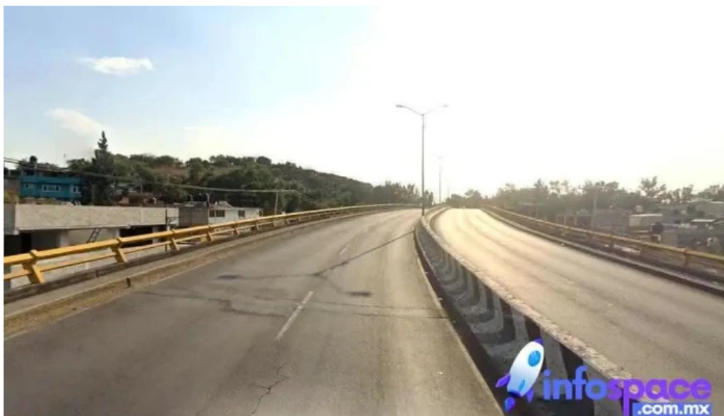
Lateral puente la pastora ciudad de mexico
