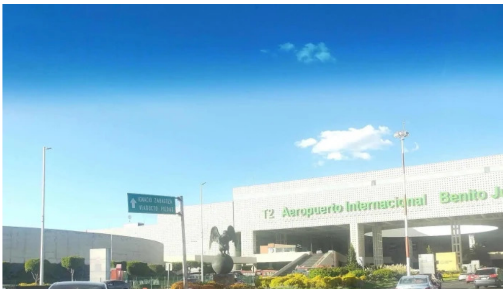
Terminal 2 aeropuerto abierto ahora
