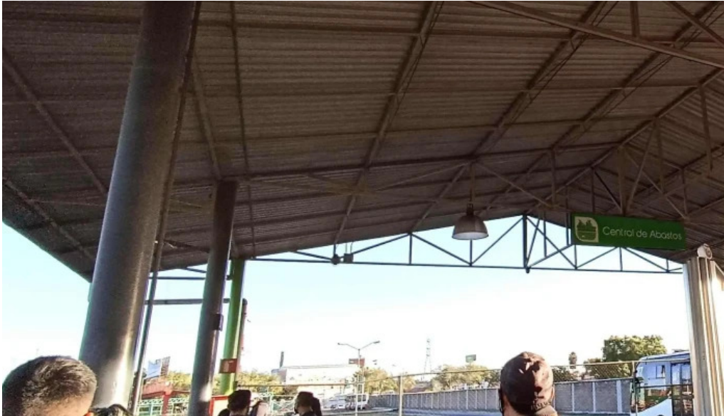
Mexibus central de abastos zona
