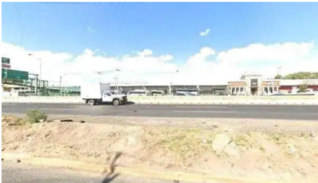
Terminal de autobuses tepotzotlan opiniones
