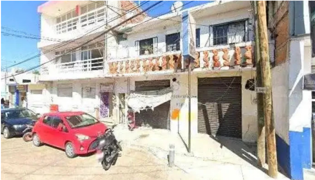
Inmuebles y terminales grupo pullman zonadeg
