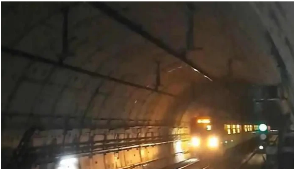
Eje central parada de tren subterraneo
