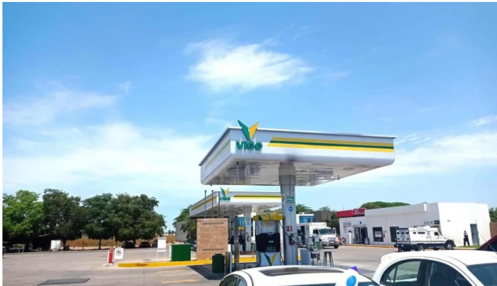
Vigo hidrocarburos estacion de servicio
