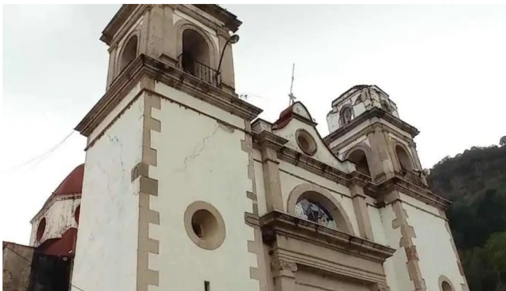
Iglesia acatzingo de la piedra comentarios
