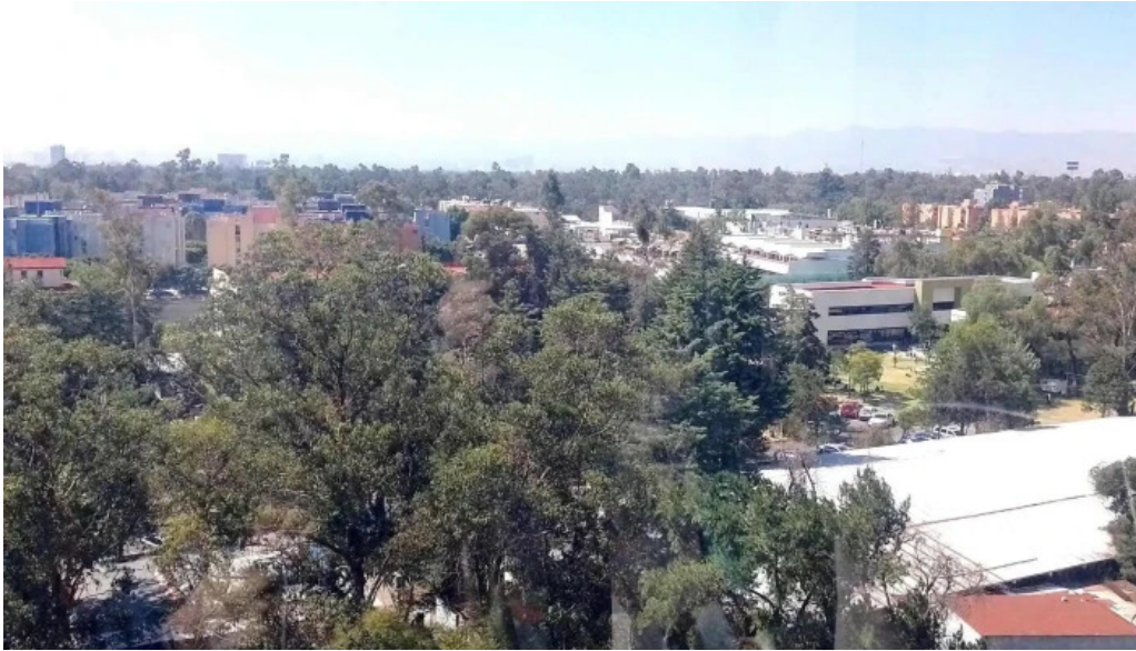
Cablebus la pastora sitio web
