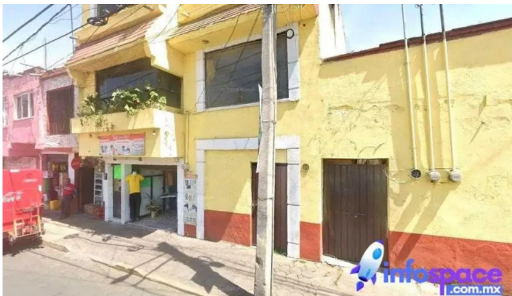
Terminal ruta huamantla san juan ocotitla huamantla
