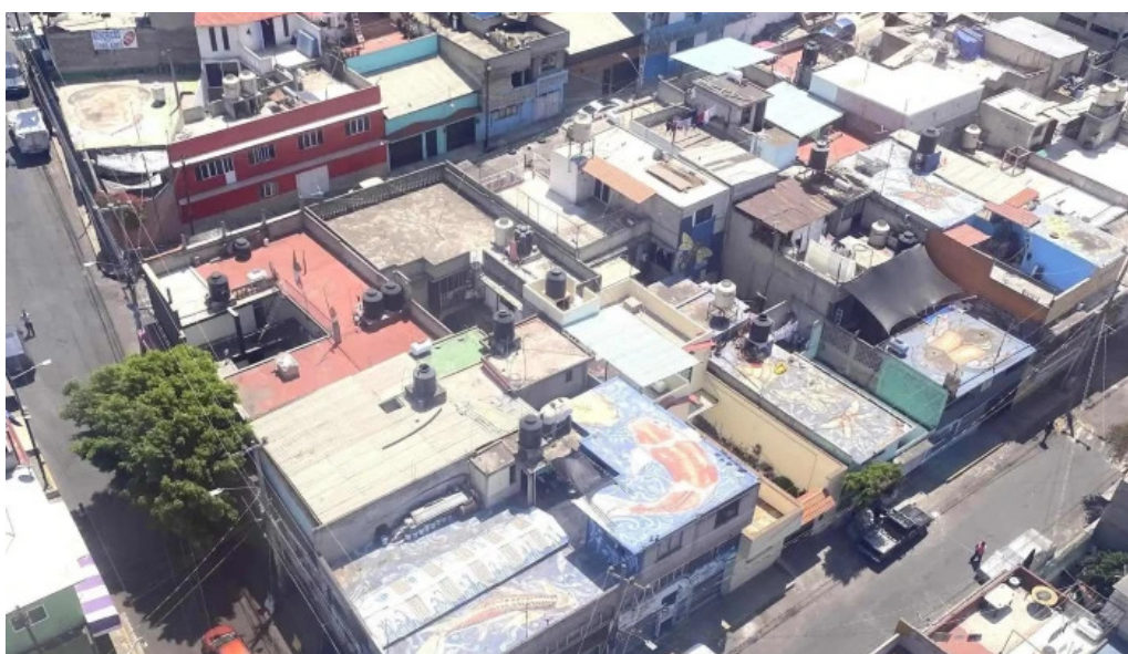
Estacion lomas de la estancia cablebus linea 2 fotos
