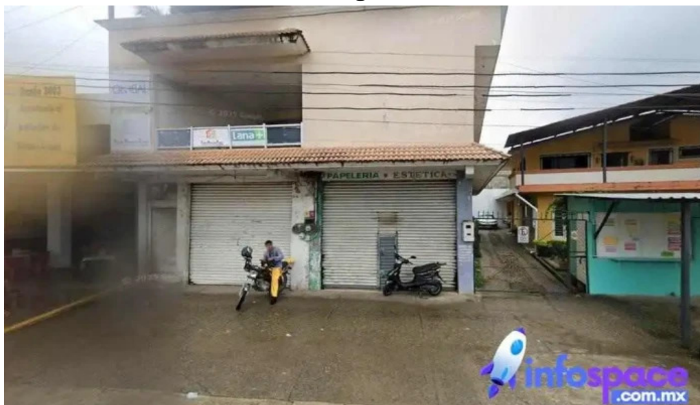
Base de transporte y carga de san pedro ixcatlan oaxaca san juan bautista tuxtepec
