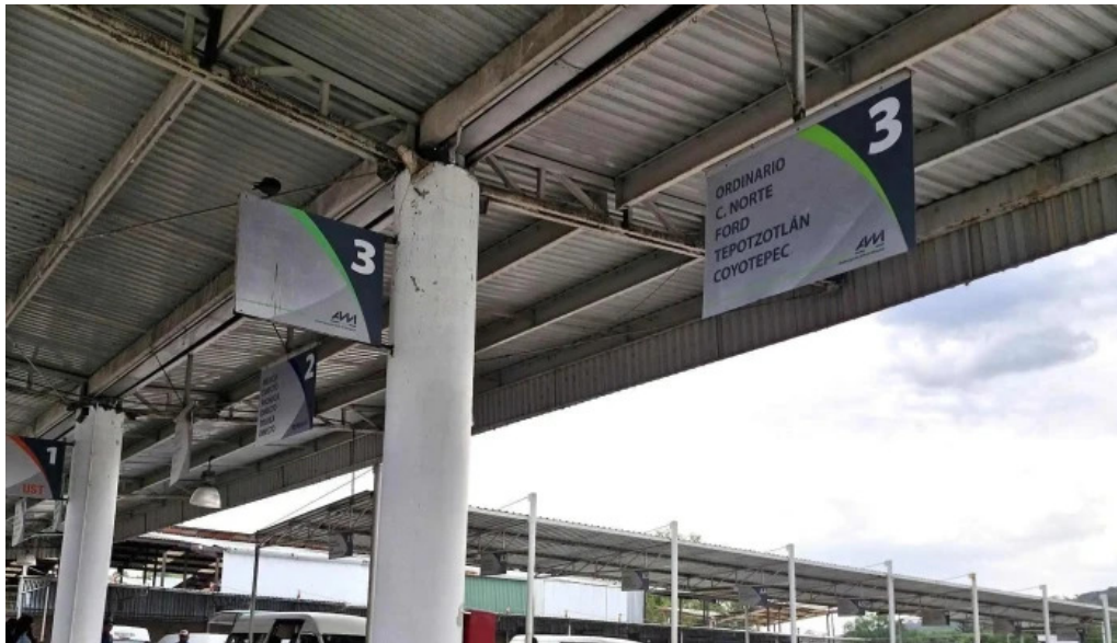
Terminal de autobuses tepeji del rio donde
