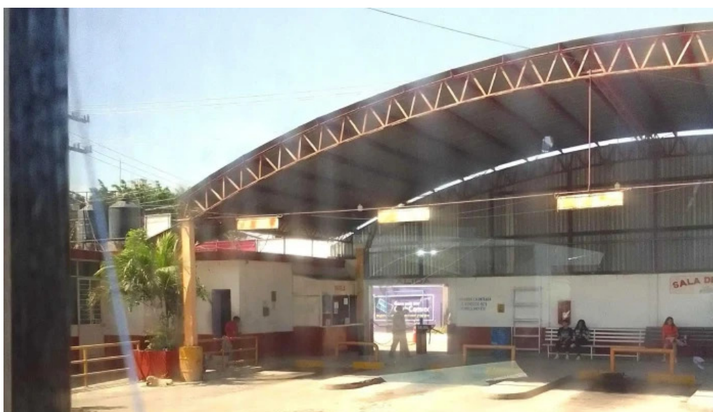
Terminal de camiones ruta 20 tezoyuca
