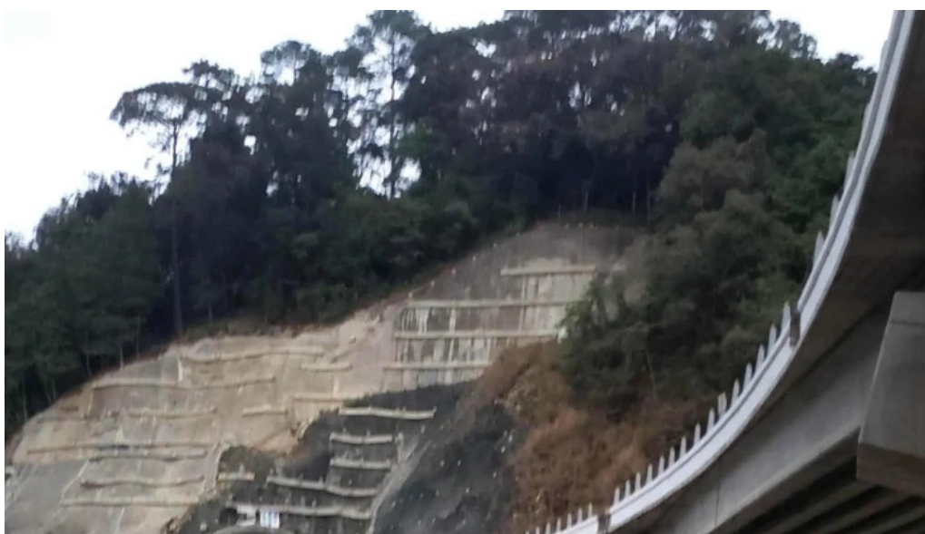
Tunel san sebastian coatlan km 51726 long 168 m direccion
